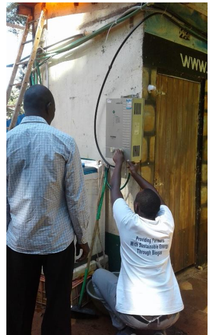
Aus diesem Durchlauferhitzer kommt sehr heißes Wasser
