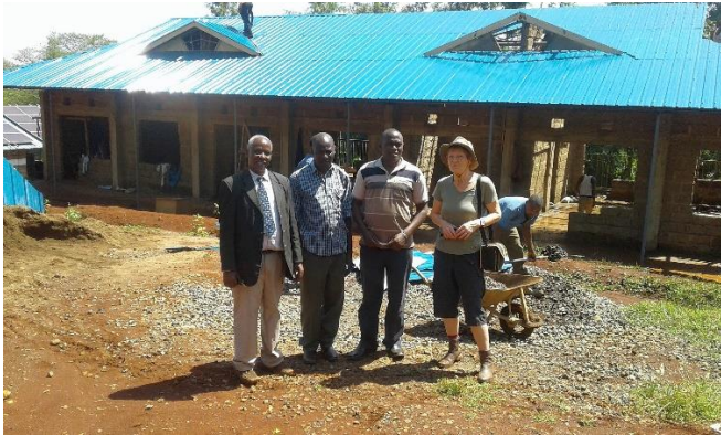
Auf das Schulgebäude wurde ein weiteres Stockwerk gesetzt.
